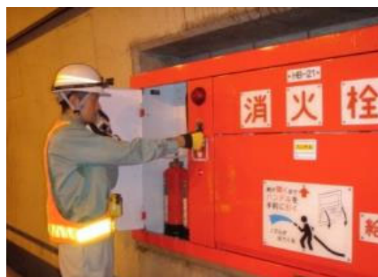
トンネル非常用設備点検
