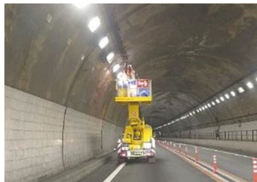
トンネル点検
