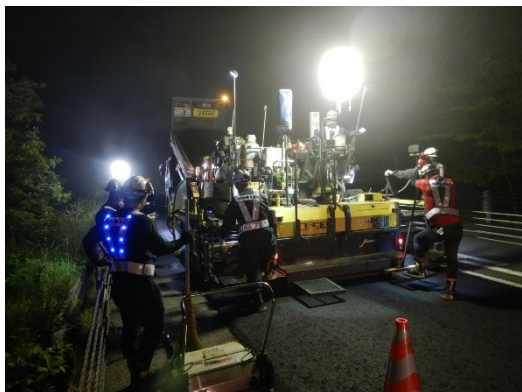
舗装工事(イメージ)
