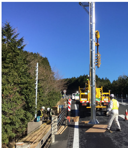
CCTV 設備 設置工事(イメージ)
