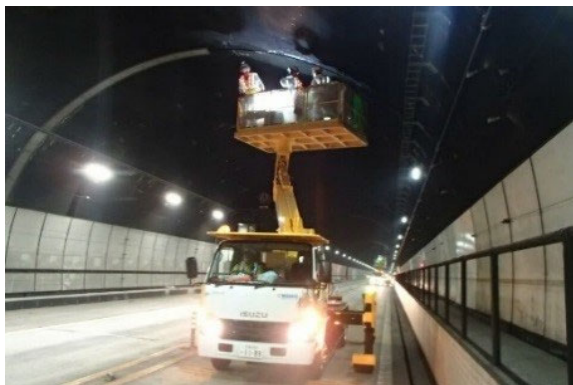
トンネル覆工点検(イメージ)
