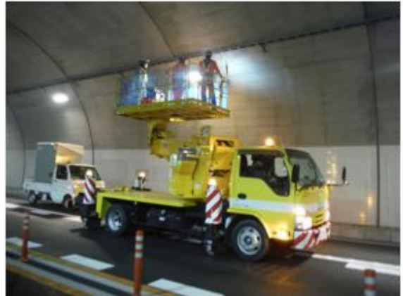
<トンネル照明設備点検状況>
