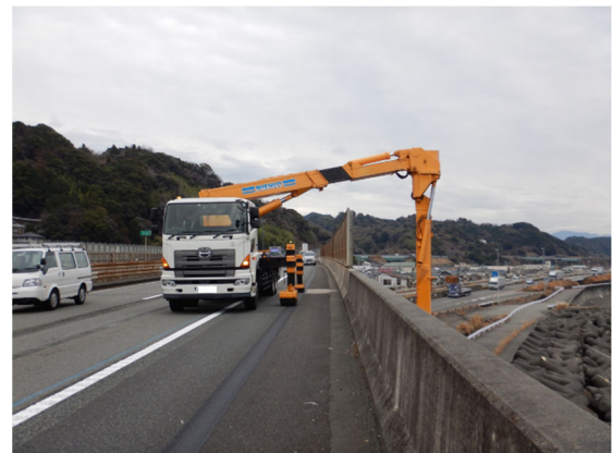
<橋梁点検車による点検状況>
