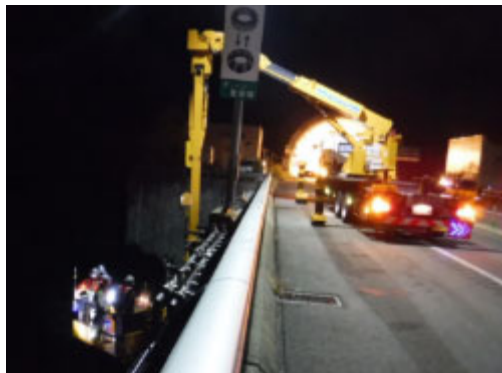
特殊点検車両による橋梁点検
