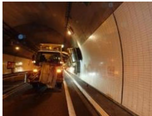
トンネルの側壁清掃
