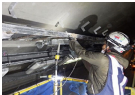
トンネル照明設備点検
