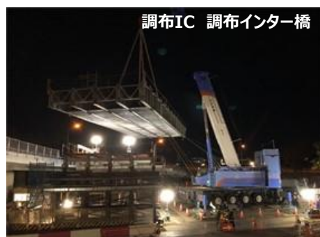
調布IC 調布インター橋 仮橋の夜間一括架設状況
