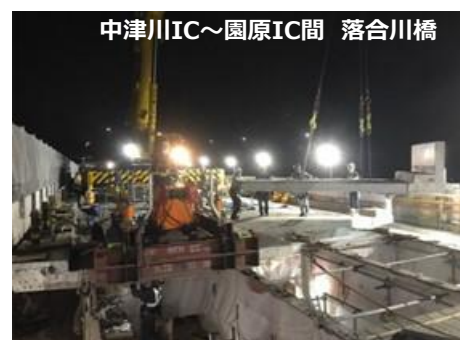
中津川IC～園原IC間 落合川橋 鋼橋の既設床版撤去状況
