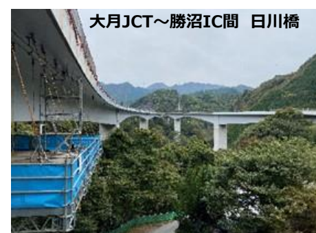
大月JCT～勝沼IC間 日川橋 P C箱桁橋のリニューアル実施状況
