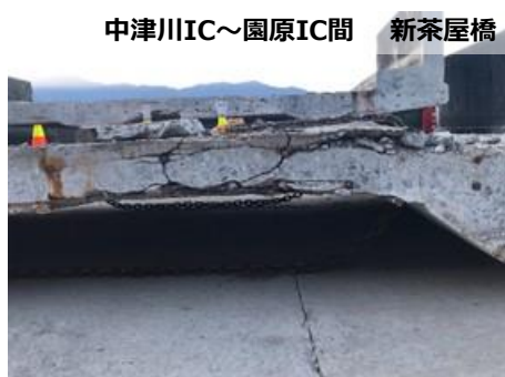
中津川IC～園原IC間 新茶屋橋 撤去した既設床版
