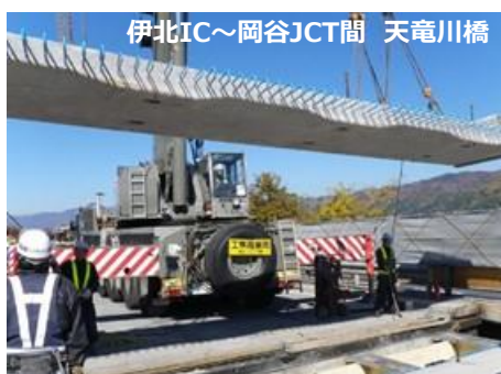
伊北IC～岡谷JCT間 天竜川橋 鋼橋の新設床版架設状況
