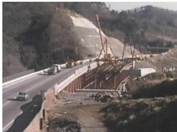
橋梁の近接施工状況
