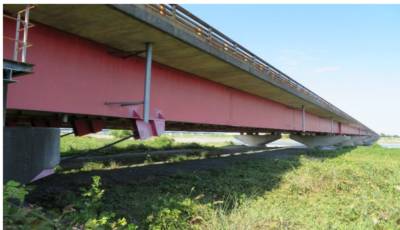
大井川橋の橋梁全景
