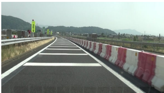
対面通行への移行区間での仮設防護柵連続化・薄層舗装の設置例
