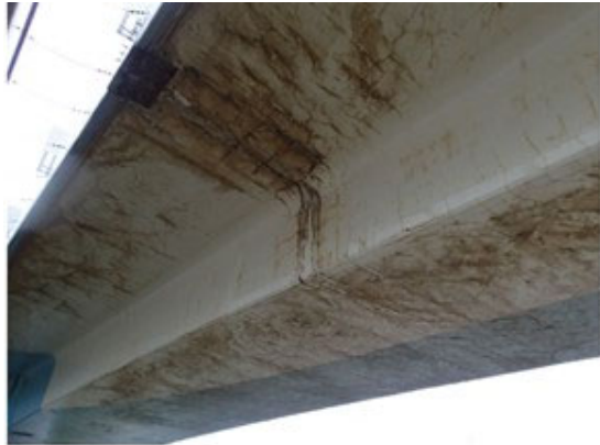
塩害により橋全体にひび割れが発生している状況
