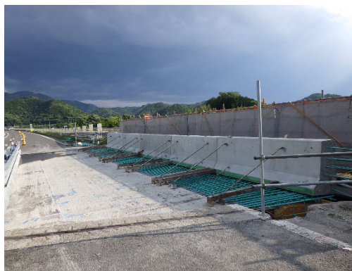
コンクリート製壁高欄の設置
