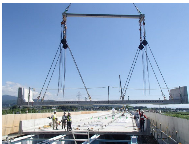
新しい床版の設置
