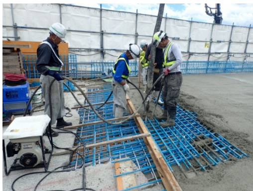
現場打ちコンクリート床版の施工
