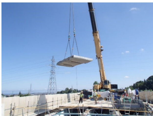
老朽化した床版の撤去
