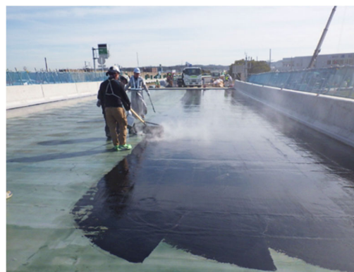
高性能床版防水の施工
