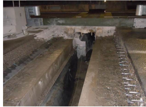
II. 橋梁伸縮装置の撤去後の状況
