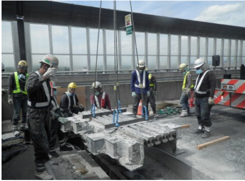
I. 既存の橋梁伸縮装置を撤去
