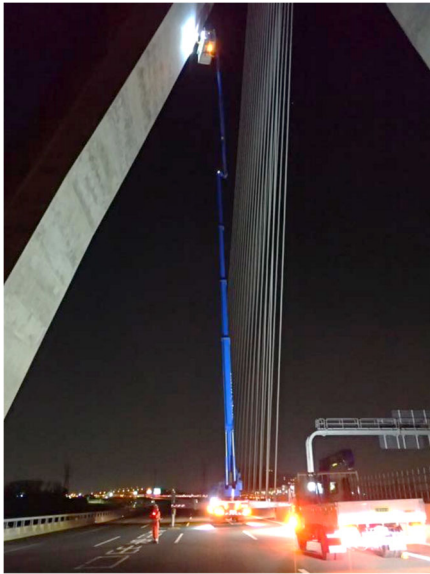
高所作業車による橋梁点検の状況
