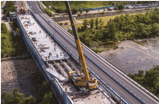
橋梁リニューアル工事(例)
