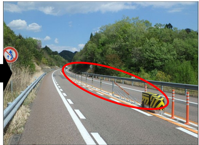
ワイヤーロープ(分離柵)設置後のイメージ
