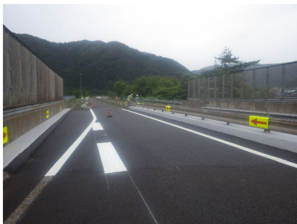
舗装補修後イメージ
