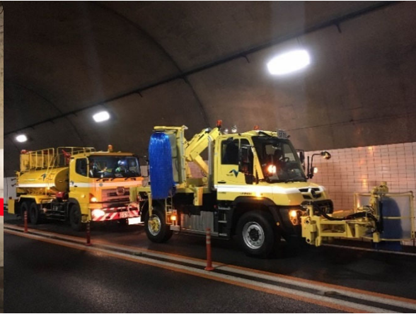
《トンネル側壁清掃》
