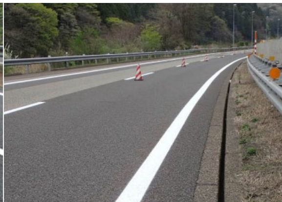
《路面標示の施工》
