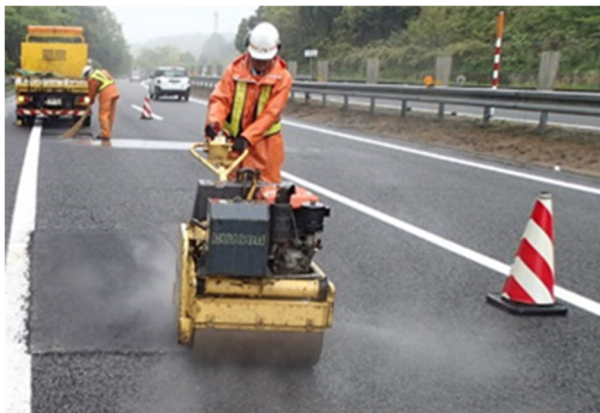
《路面損傷箇所の補修》
