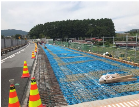
コンクリート床版の打設工事(中央道 弓振川橋施工時の工事の様子 2021年6月撮影)
