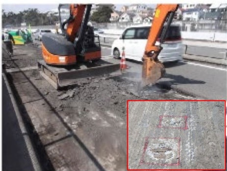
舗装撤去状況・床版損傷状況
