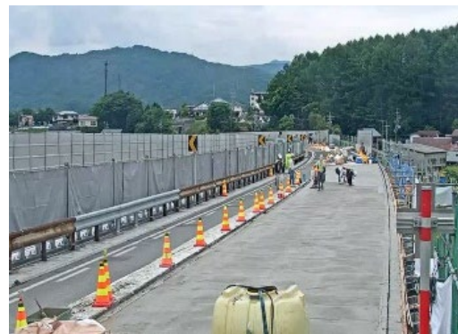
コンクリート床版の打設工事(中央道 弓振川橋施工時の工事の様子 2021年6月撮影)
