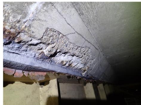
深沢橋（上り線：床版下面）の損傷状況写真
