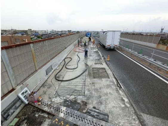
舗装・床版補修状況
