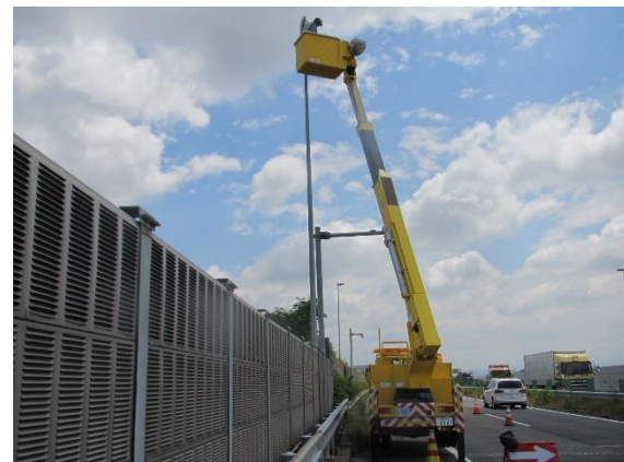
道路照明設備の点検
