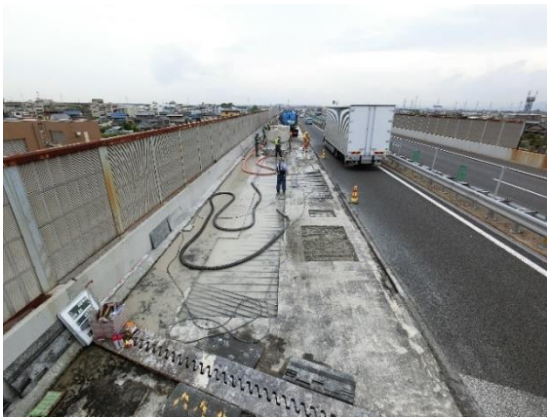
はじめに、床版補修をおこないます
