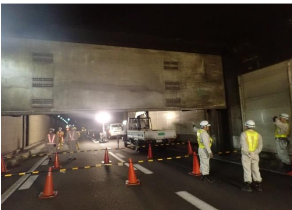
制水ゲートの点検
