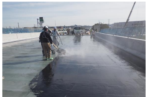
次に、高性能床版防水工を施工します
