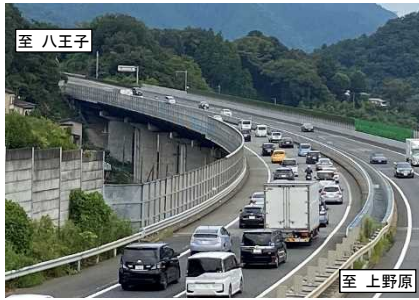
<小仏 TN 付近（上り線）の渋滞状況（2020.9）>
