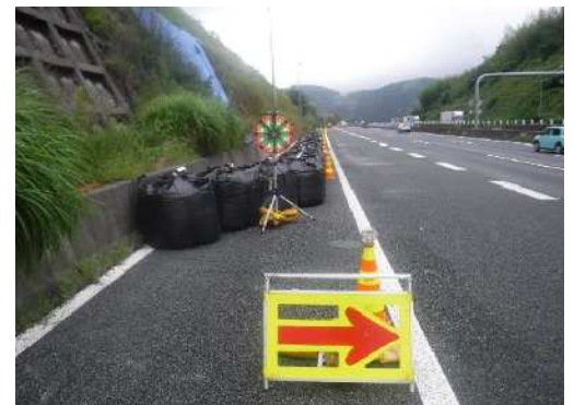
規制材設置状況(飛散前)
