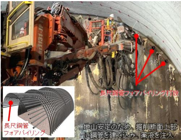
長尺鋼管フォアパイリング
