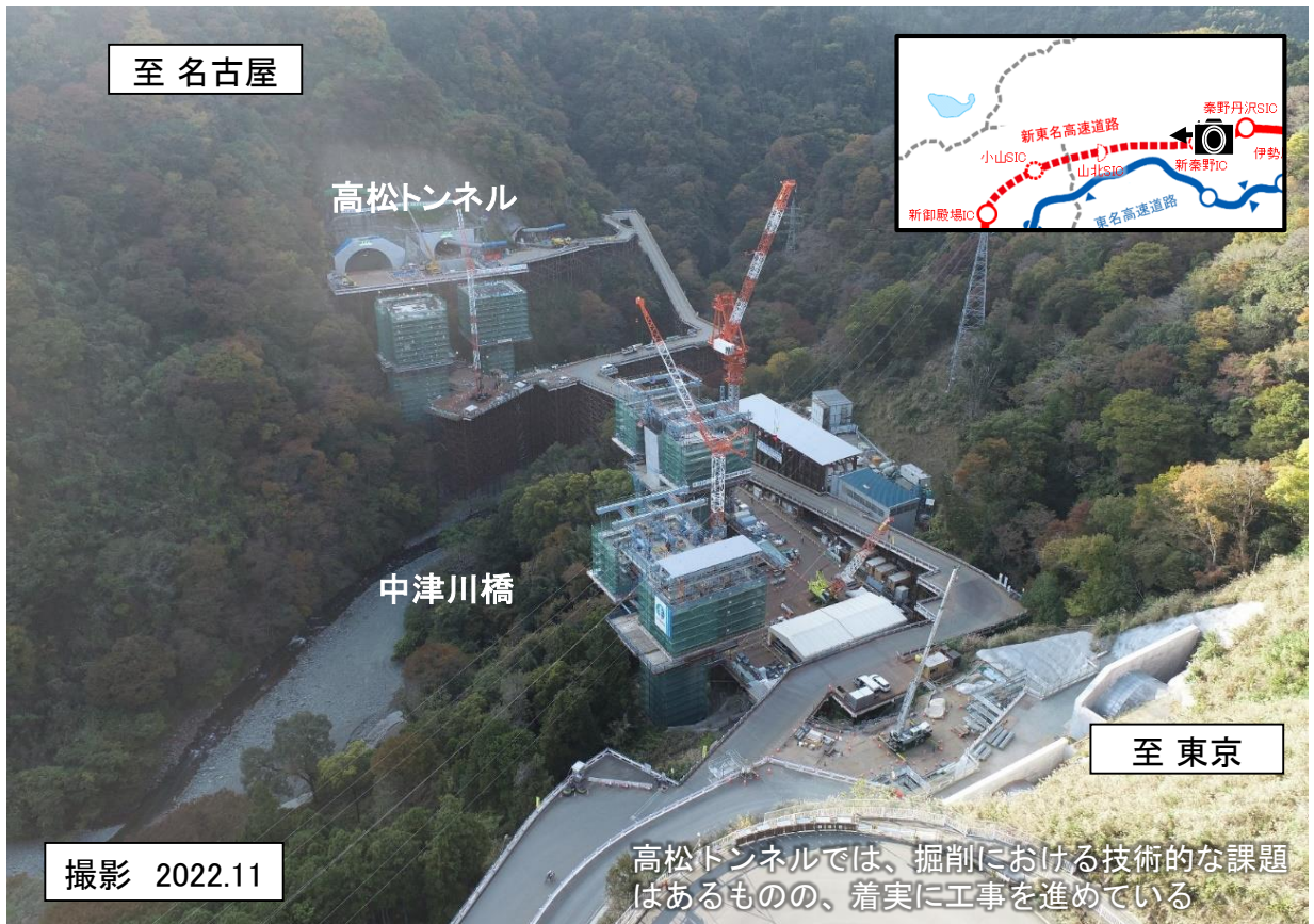
高松トンネル付近（松田町域）
