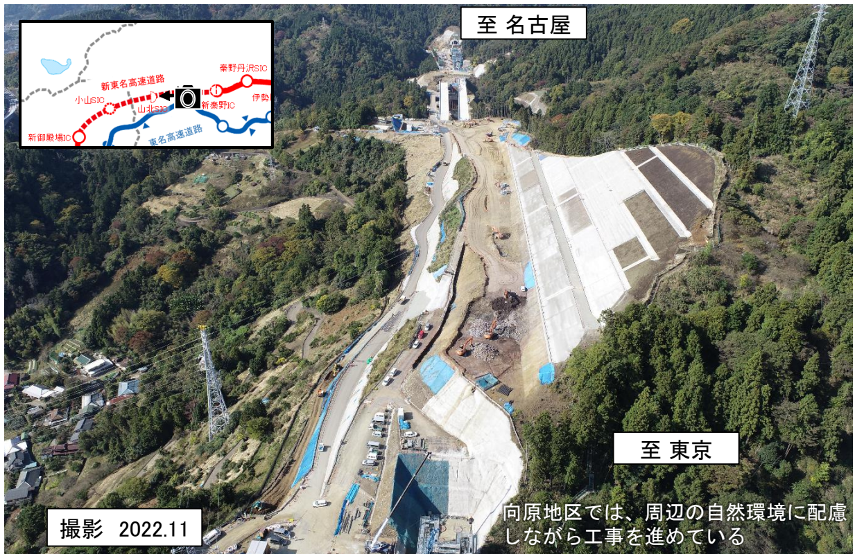
向原切土付近（山北町域）
