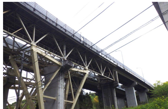
滝沢川橋の橋梁全景
