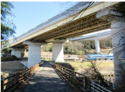
所領橋の橋梁全景
