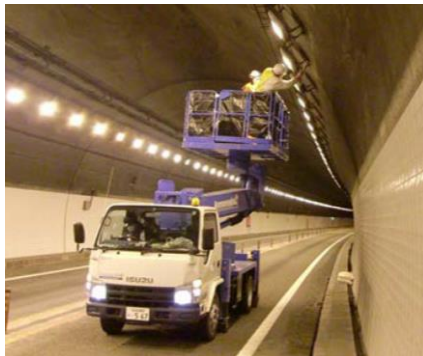
【通行止めによるトンネル内の点検】
