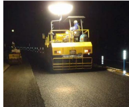
【通行止めによる舗装補修工事】
