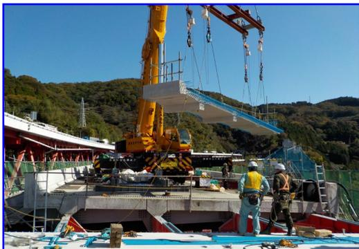
大型クレーンによる全断面床版取替 (従来)
