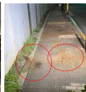
調布市道への鉄錆片の落下状況)
