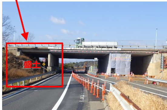
今回復旧を行う盛土(写真は盛土撤去前の状況)
