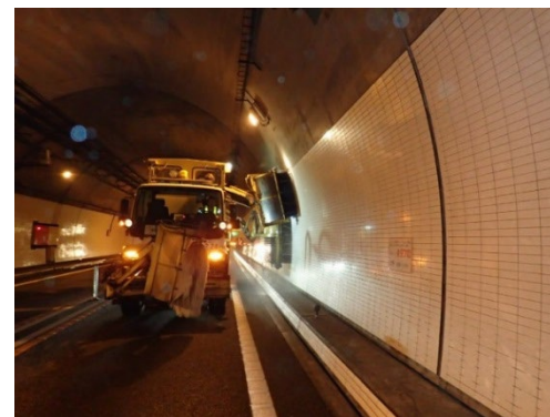
トンネルの側壁清掃
