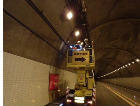
トンネル照明設備点検
