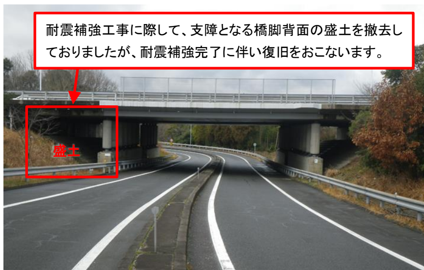
今回復旧を行う盛土(写真は耐震補強工事前の状況)
