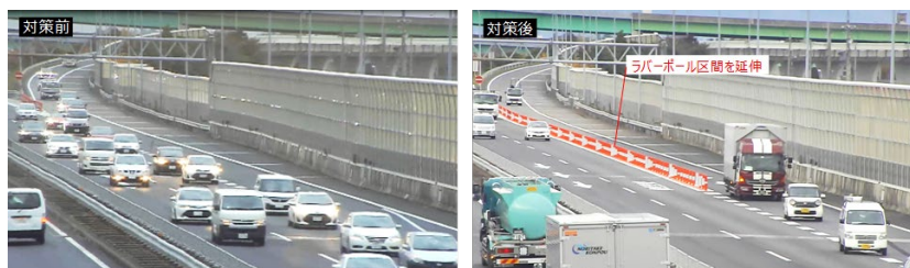
対策前後の交通状況(一宮 JCT 付近)
