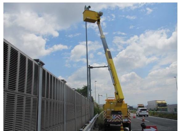
道路照明設備の点検
