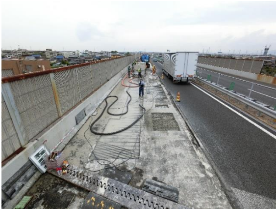
床版補修状況
