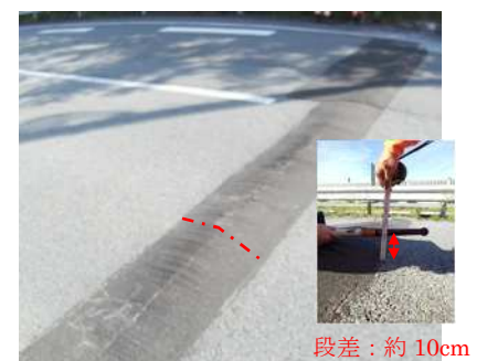
路面損傷状況
