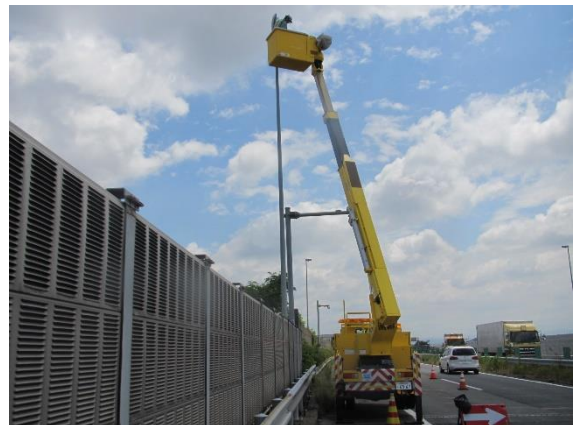
道路照明設備の点検
