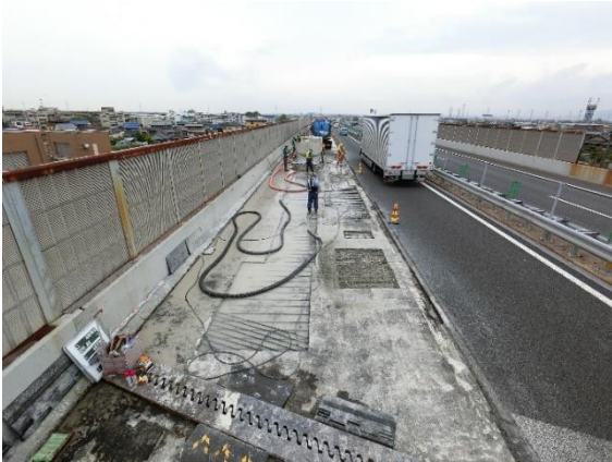
床版補修状況
