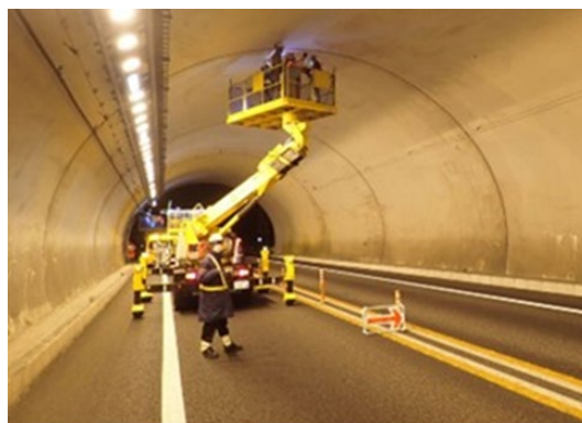
トンネル点検
