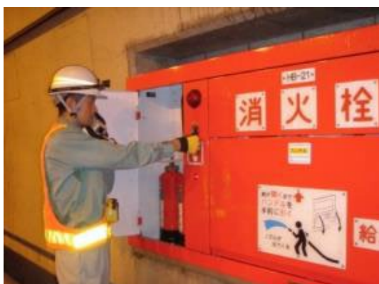
トンネル非常用設備点検
