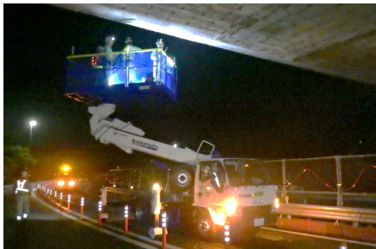
橋梁点検状況
