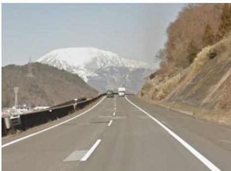
舗装損傷状況
