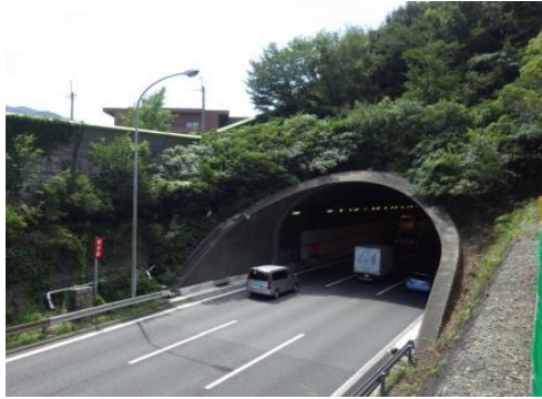
樹木繁茂状況
