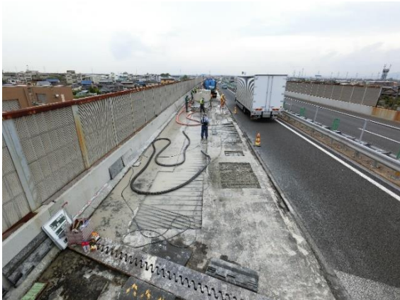
舗装・床版補修状況
