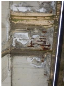
中津川橋の中央分離帯張り出し部損傷状況※床版を下から撮影
