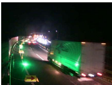
視線誘導の設置例
