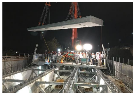
プレキャスト床版の施工
