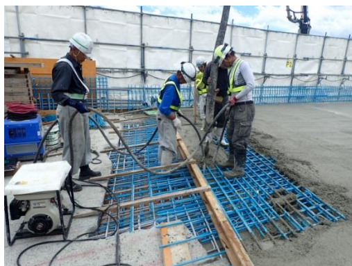
現場打ち床版の施工
