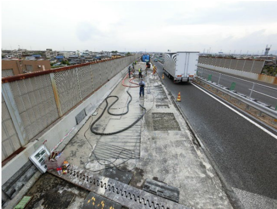
舗装・床版補修状況
