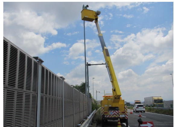
道路照明設備の点検
