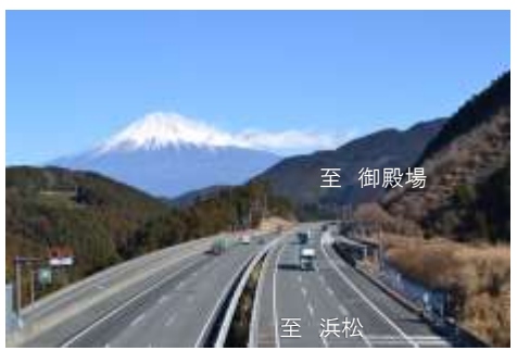
新東名6車線区間
