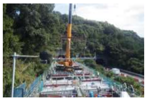
山居沢橋(床版取替):2021年
