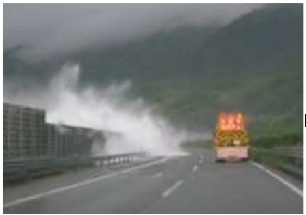
越波による通行止めの様子 (東名 富士IC～清水JCT)
