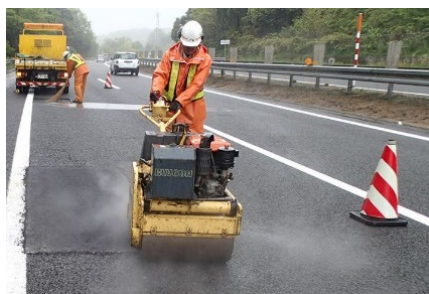
《 路面損傷箇所の補修 》
