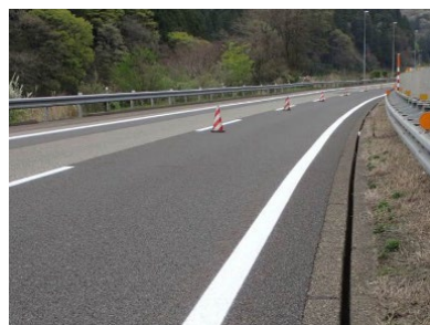
《 路面標示工の施工 》
