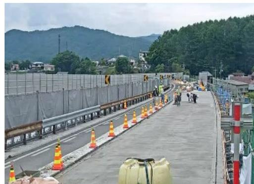
コンクリート床版の打設工事(走行車線施工時の工事のようす 2021年6月撮影)
