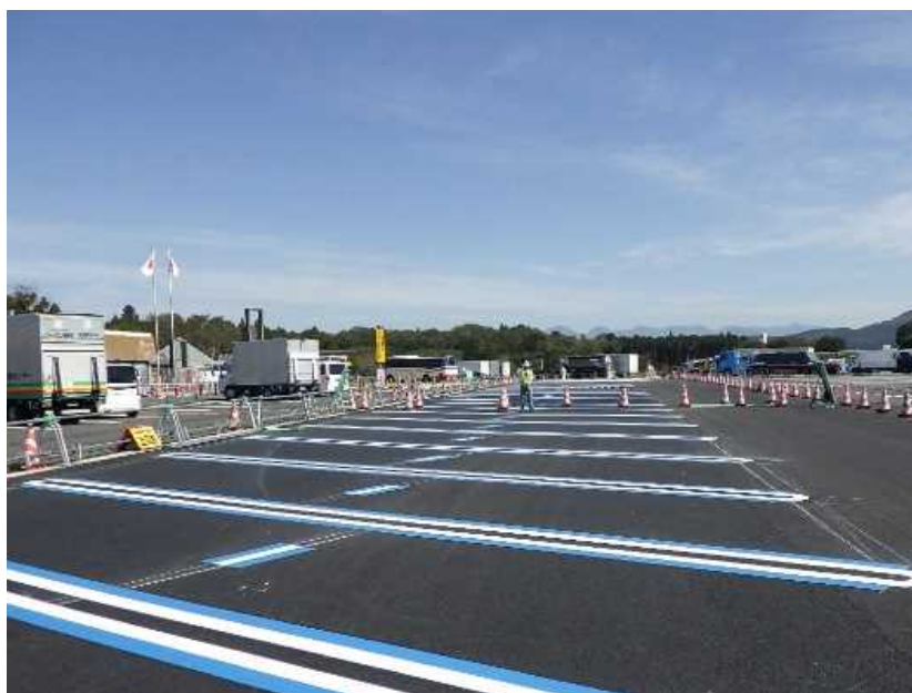
写真 2 兼用マスの完成状況
