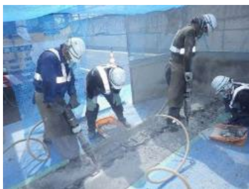
施工中イメージ
