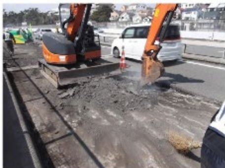
舗装撤去状況
