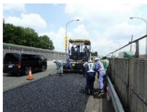
舗装工事イメージ
