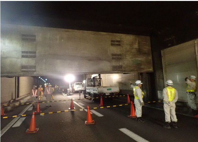
制水ゲートの点検
