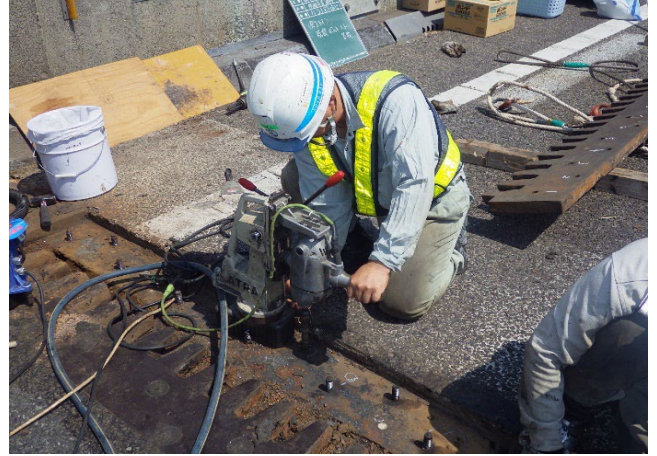
橋梁伸縮装置補修工事
