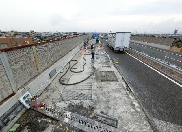
舗装・床版補修工事
