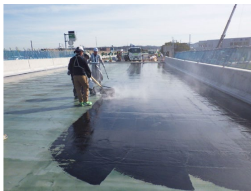
高性能床版防水の施工
