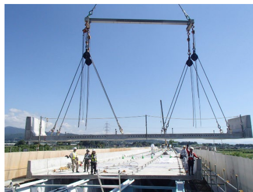
プレキャスト床版の施工
