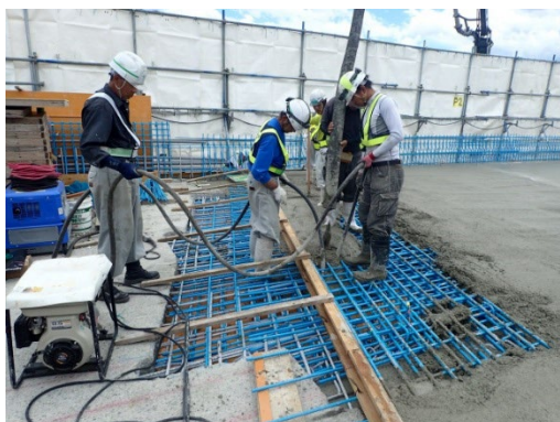
現場打ち床版の施工
