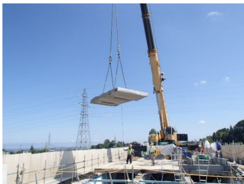
老朽化した床版の撤去
