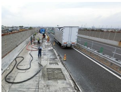
老朽化した床版の補修
