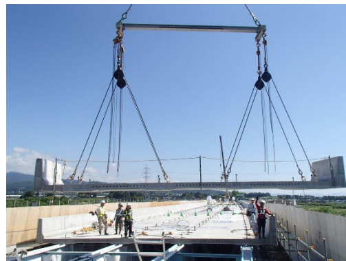
新しい床版の設置
