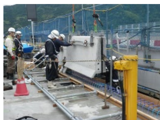
【プレキャスト壁高欄の施工状況】
