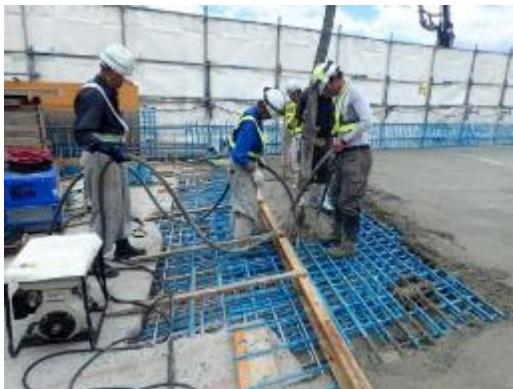
【現場打ち床版の施工状況】
