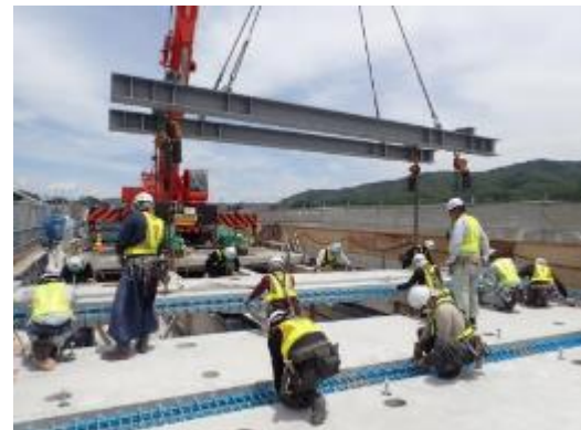
【プレキャスト床版の施工状況】
