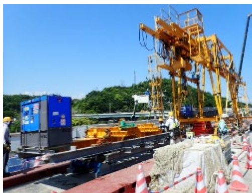
【床版取替機による床版設置状況】
