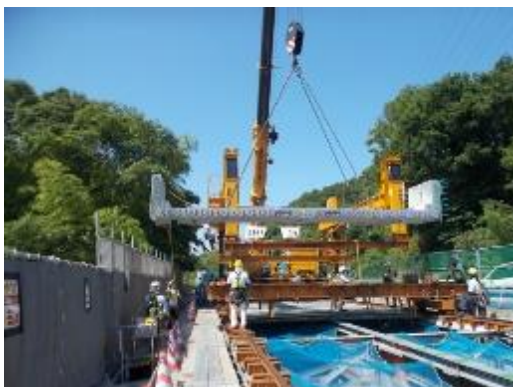
【床版&壁高欄一体化後の設置状況】
