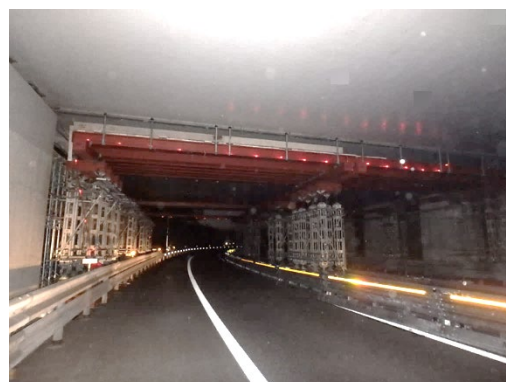
足場設置状況 (イメージ)
