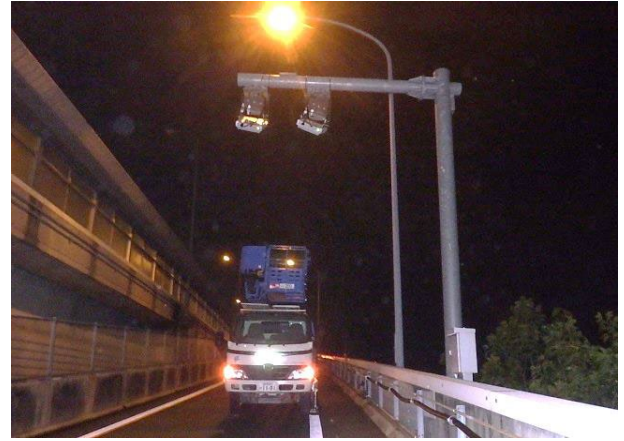
ETC アンテナ設備点検
