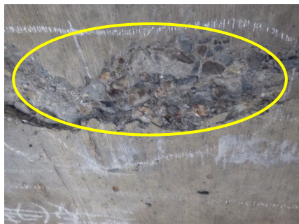
(コンクリートの剥落)
