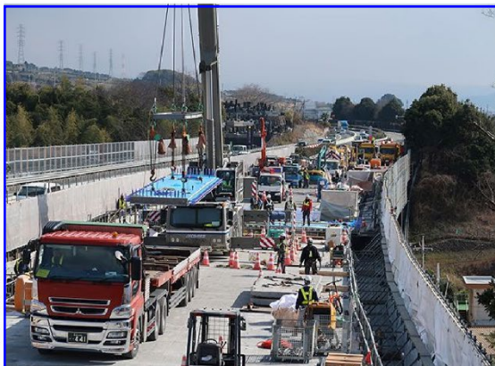
大型クレーンによる全断面床版取替（従来）
