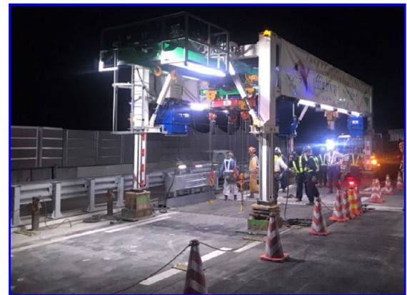
移動床版架設機による分割断面床版取替（今回）
