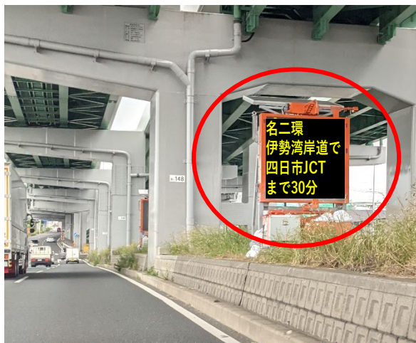
仮設 LED 標識の設置例
