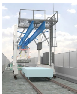
床版を撤去・設置する 門型のクレーン (今回の手法)
