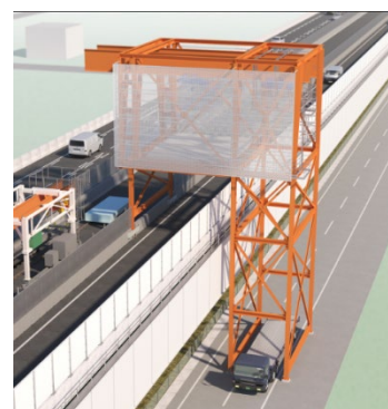
資機材の搬出入作業イメージ
