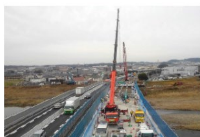
一般的におこなわれる 大型クレーンでの床版取替 (従来手法)
