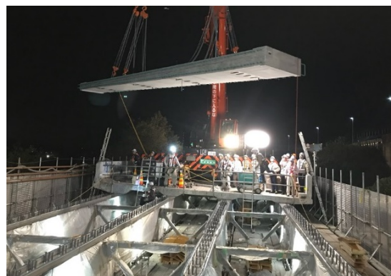
プレキャスト床版の施工
