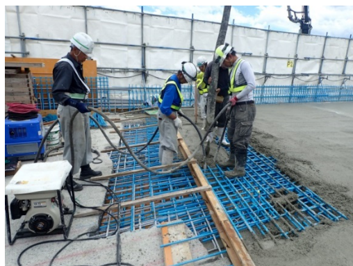
現場打ち床版の施工
